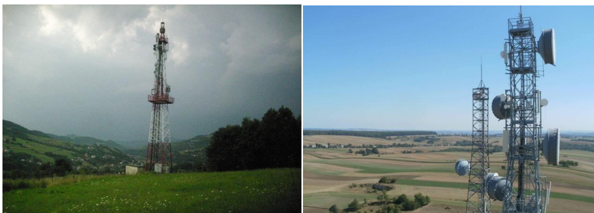
Fot.1. Obiekt nadawczy w Rytrze i Książu Wielkim (A.Konieczna)
