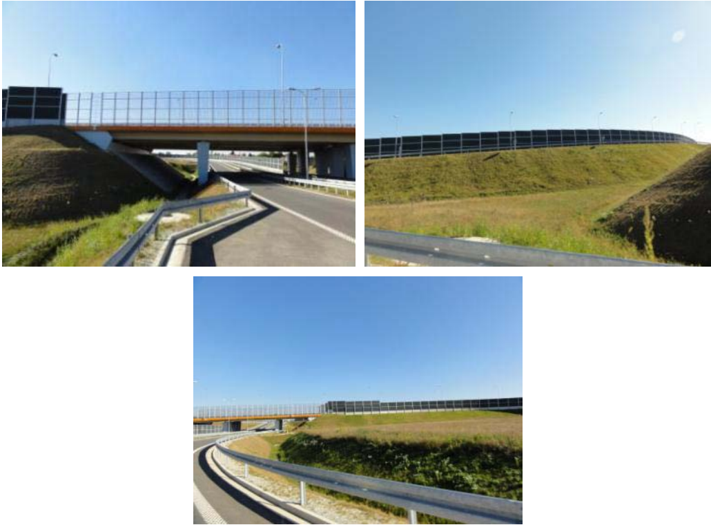
Autostrada A4 - Węzeł autostradowy Wierzchosławice (Tarnów-Zachód) (fot. Teresa Prajsnar)
