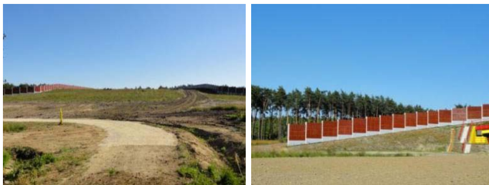
Przejście dla zwierząt na autostradzie A4 na odcinku Brzesko-Tarnów (fot. Teresa Prajsnar)
