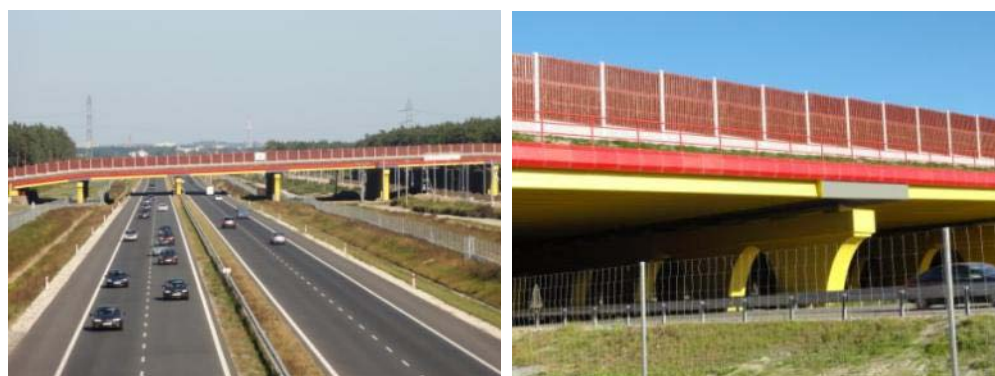
Zachowanie ciągłości korytarzy ekologicznych i szlaków migracyjnych zwierząt – przejście dla zwierząt na autostradzie A4 na odcinku pomiędzy węzłami Brzesko i Wierzchosławice (Tarnów-Północ) oraz linii kolejowej Kraków-Tarnów (fot. Teresa Prajsnar)
